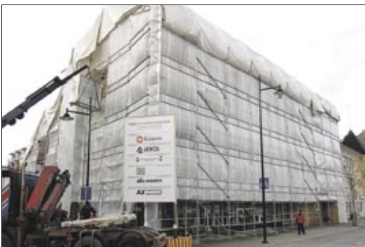
Akaan keskustassa sijaitsevan Kauppahuoneen omistaja Akaan Seudun Osuuspankki on ollut liikkeellä oikeaan aikaan. Kokonaan huputettu kiinteistö uudistuu parhailaan täydellisesti.
