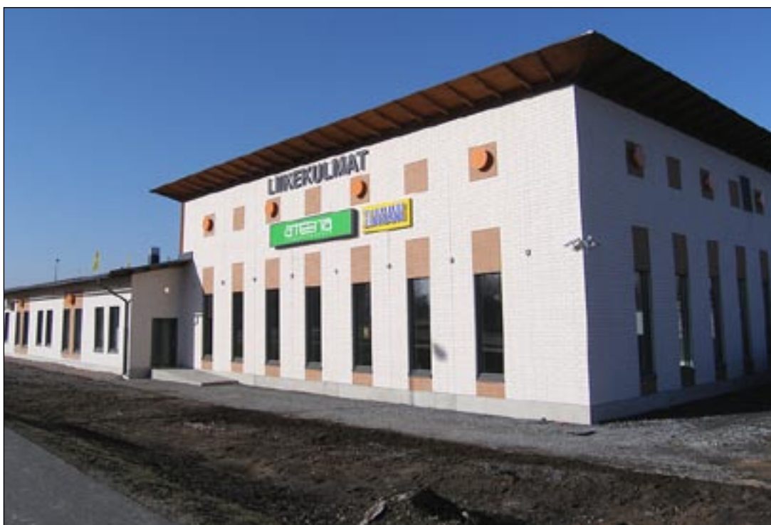
Liikekulmat on hyvä esimerkki kohteesta, jossa Arkta-konserni rakentaa, omistaa ja hallinnoi kiinteistöjä. Ajoissa mukaan tulevat vuokralaiset pääsevät vaikuttamaan omien tilojensa ratkaisuihin.
